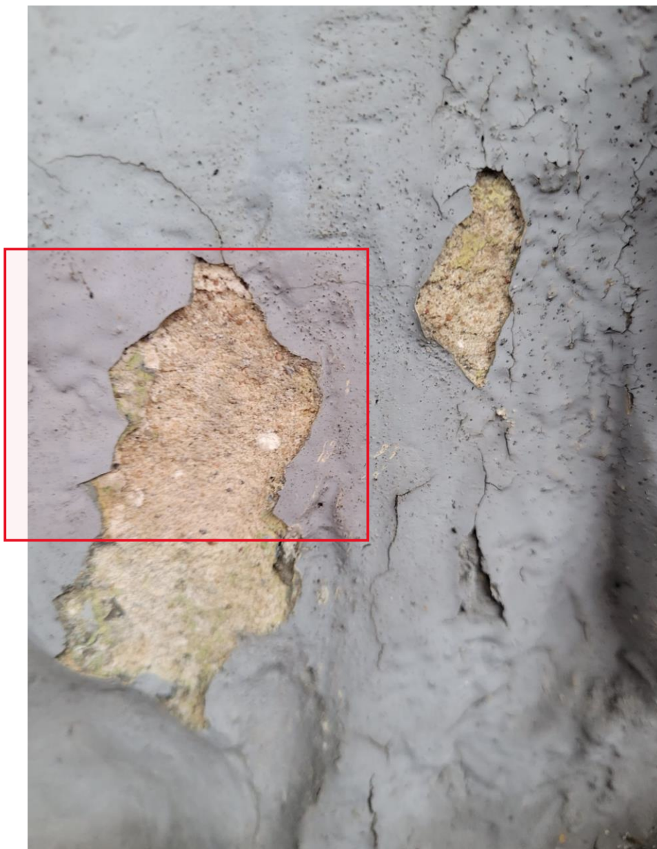
Osuchów, kapliczka św. Jana Nepomucena- fragment rzeźby Świętego, odslonięty fragment kamienia – widoczne uzupełnienia zaprawą
