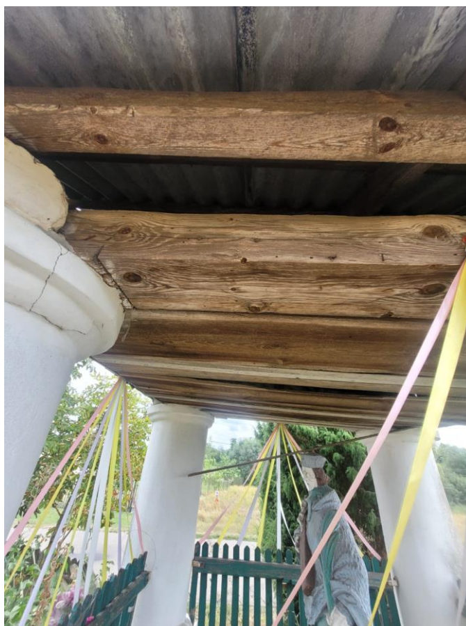
Osuchów, kapliczka św. Jana Nepomucena - deskowanie stropu
