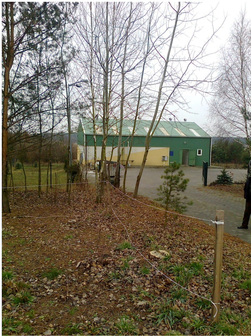
Oczyszczalnia Kazanów stan istniejący
