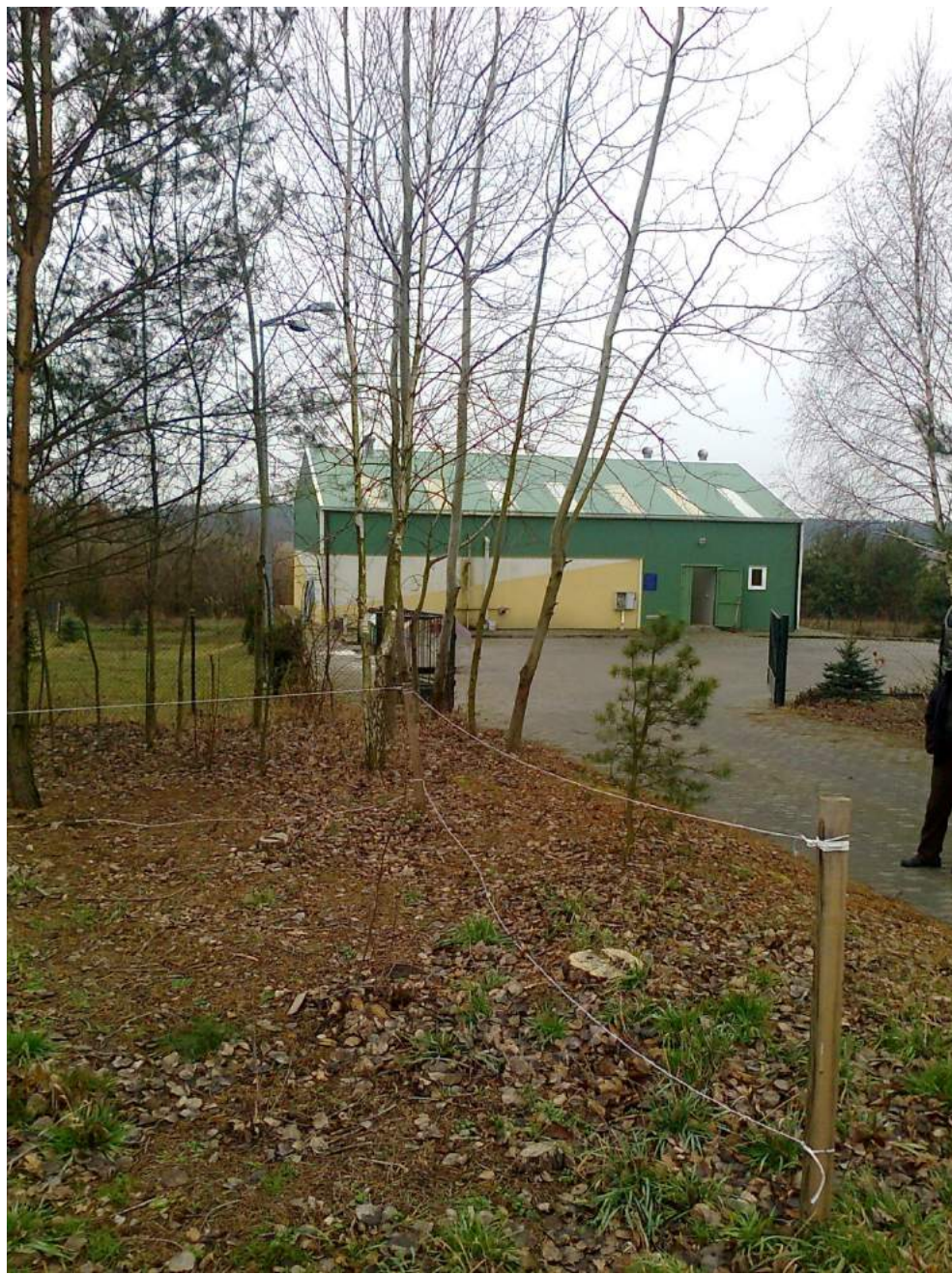
Oczyszczalnia Kazanów stan istniejący
